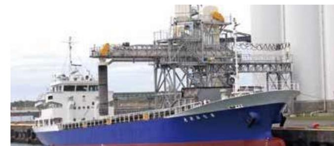
サイロより直接搬送する船積設備。400トン/時の積み込み能力があります。
