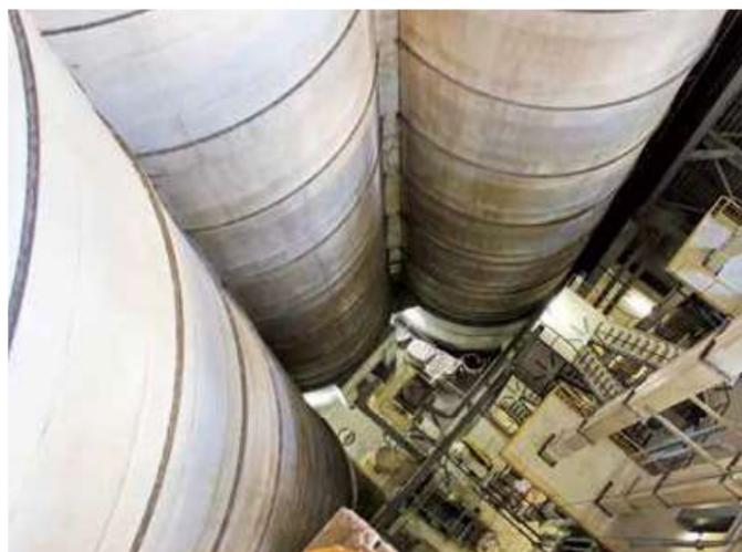
鋼鉄製の円形サイロビンは総計105本有ります。その内7割のサイロビンが高さ40m・直径8.6mと大型で、約1500トン/1本の飼料原料を保管する容量を有しております。アンローダーで荷揚げされた原料はサイロ棟の中に入ると、セパレーターにより、異物除去が行われます。その後、原料種類・産地・船毎に分別、計量後、サイロビンにて保管されます。
